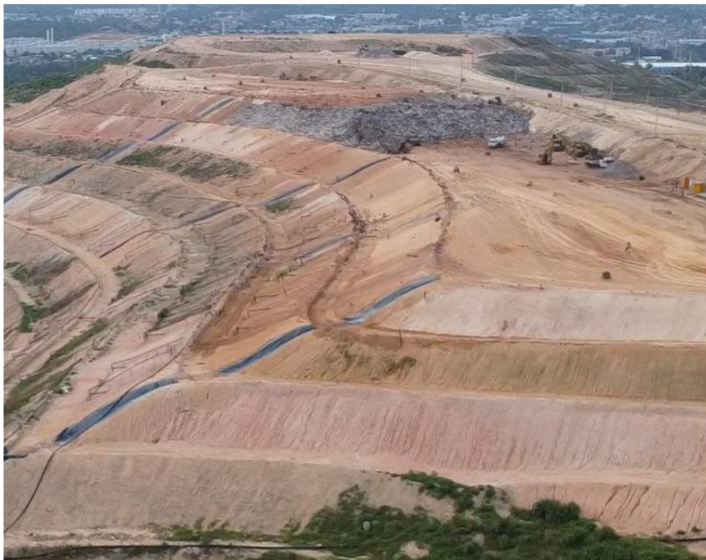
Figura 42 Frente de operações do descarte dos resíduos sólidos no Aterro
