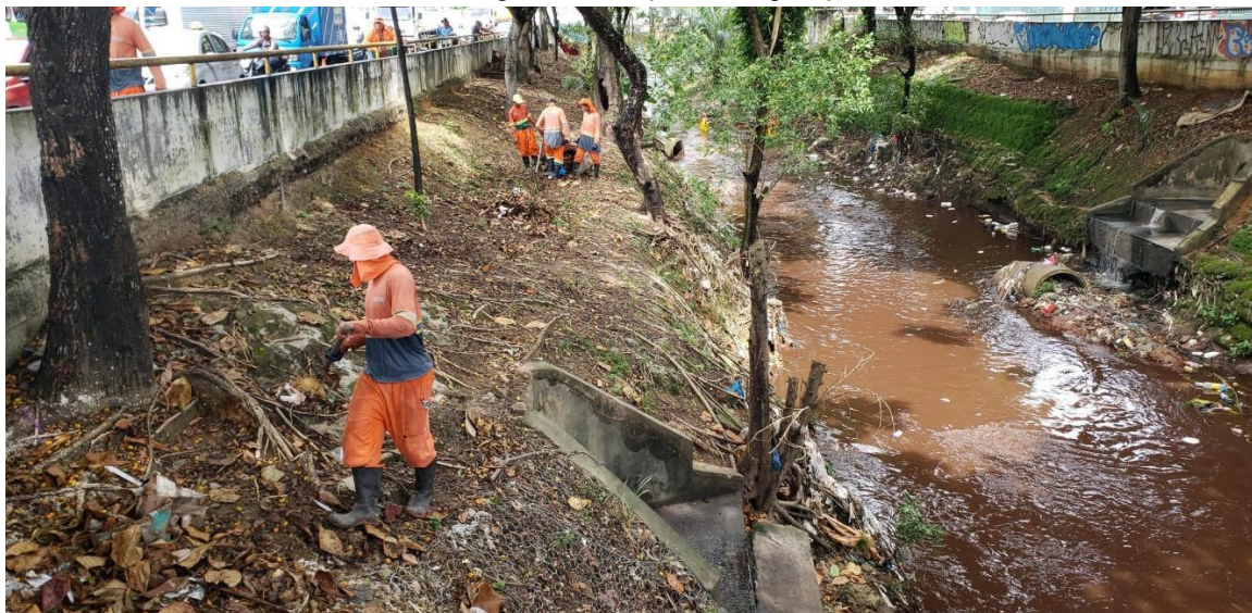
Figura 20 Limpeza de Igarapé
