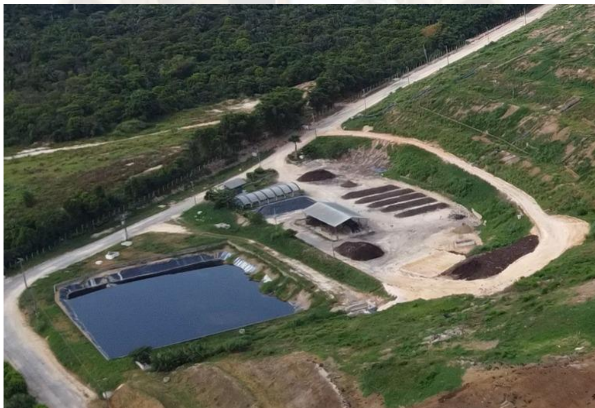
Figura 44 Usina de Compostagem
