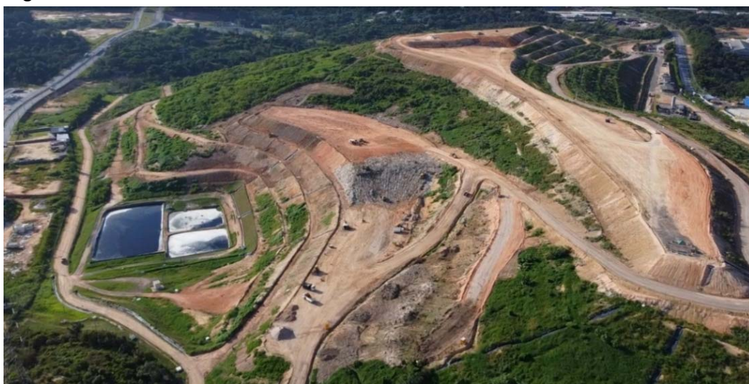
Figura 50 Vista aérea da Célula de descarte dos resíduos sólidos no Aterro
