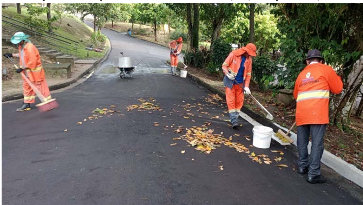
Figura 10 Serviços de Pintura de Meio-Fio no parque Lagoa do Japiim
