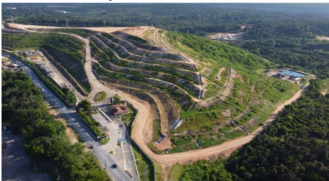
Figura 49: Vista área do Aterro
