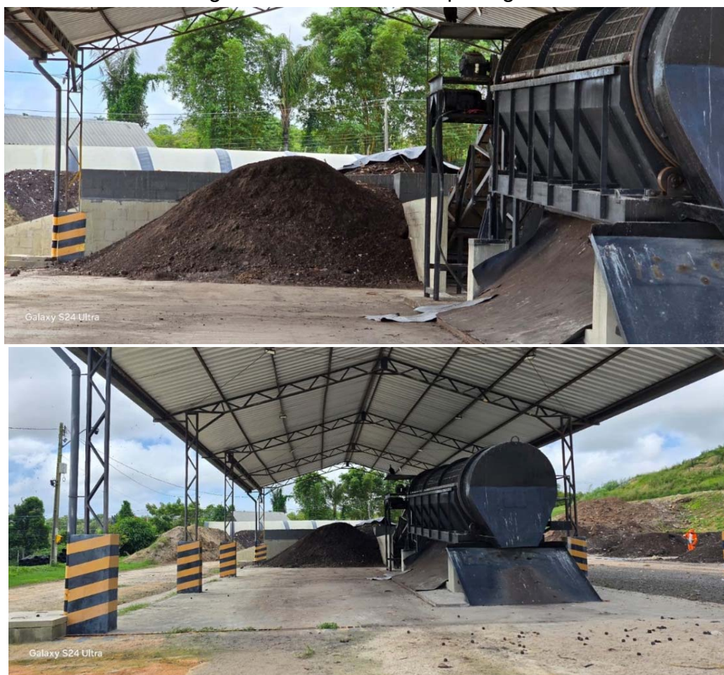
Figura 53: Usina de Compostagem
