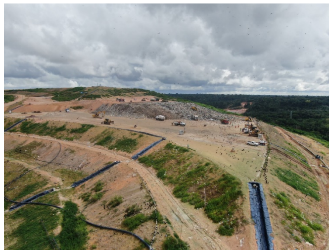
Figura 37: Vista aérea da Célula de descarte dos resíduos sólidos no Aterro
