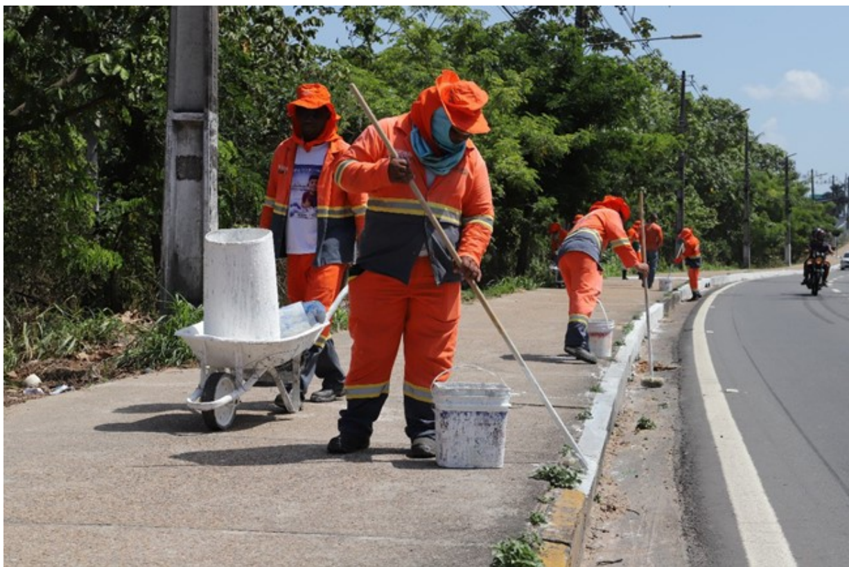
Figura 9: Semulsp avança com serviço de pintura de meio-fio na avenida Governador José Lindoso
