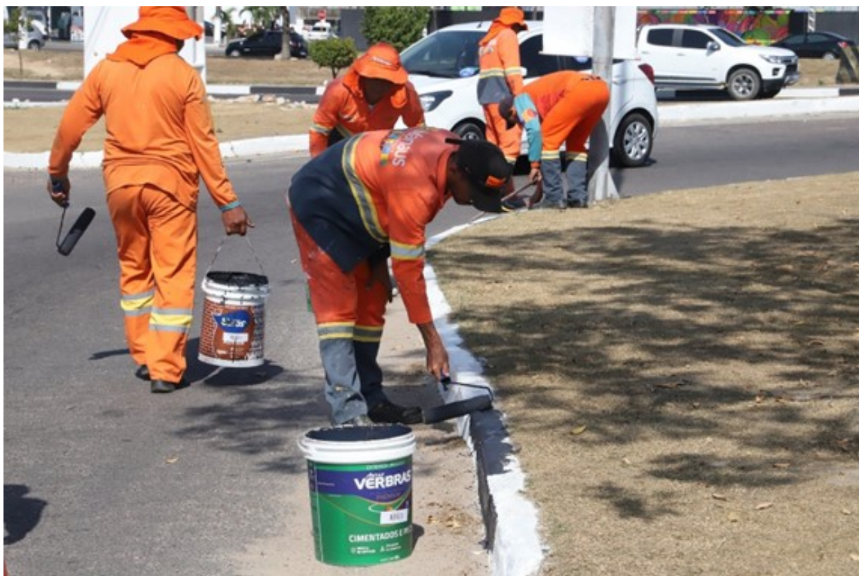
Figura 8: Avenida Nathan Xavier recebe pintura de meio-fio -
