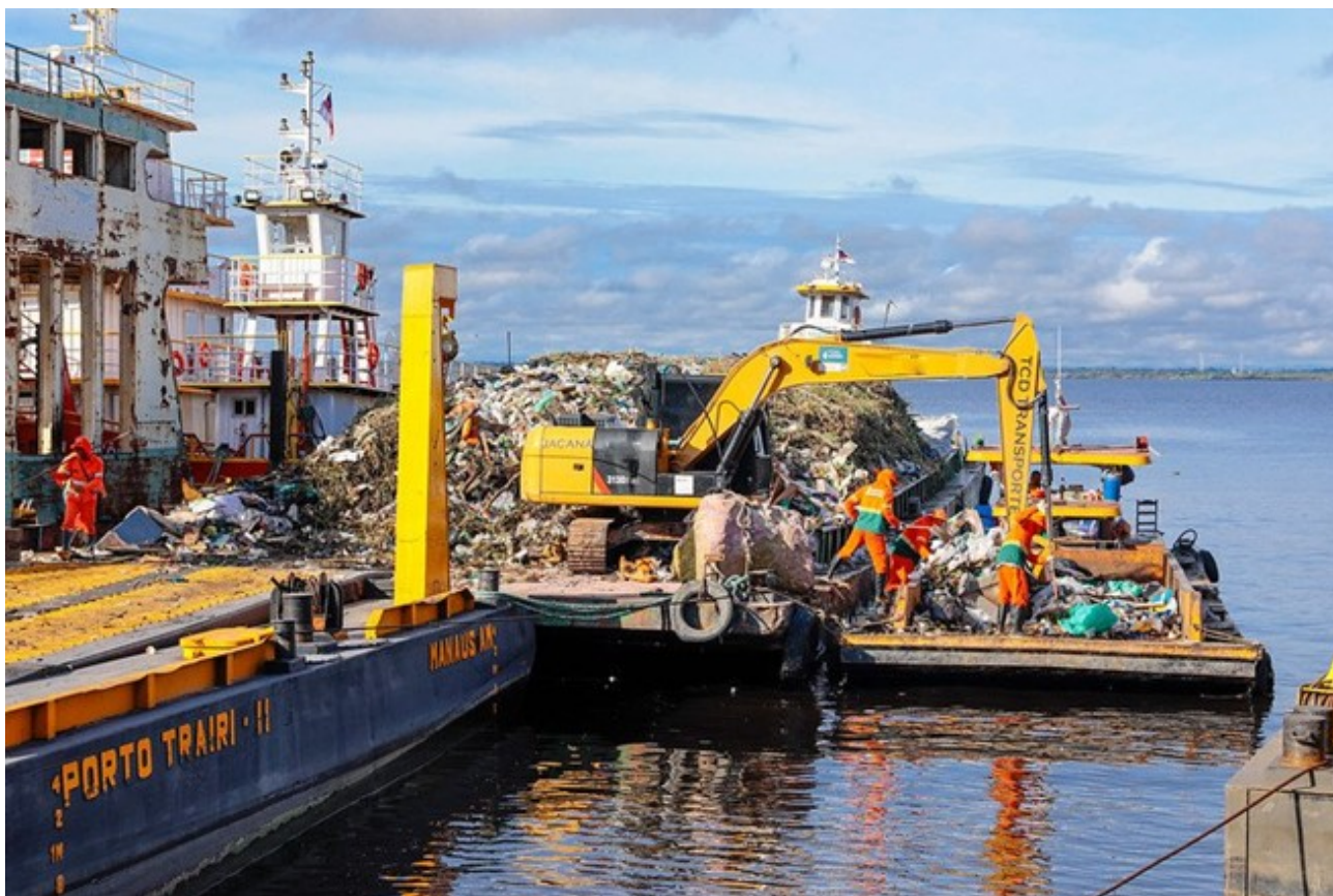
Figura 28: Transbordo de resíduos retirados dos rios e igarapés -
