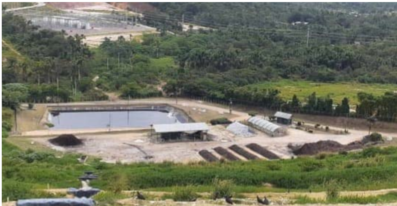
Figura 37: Usina de Compostagem do Aterro de Manaus
