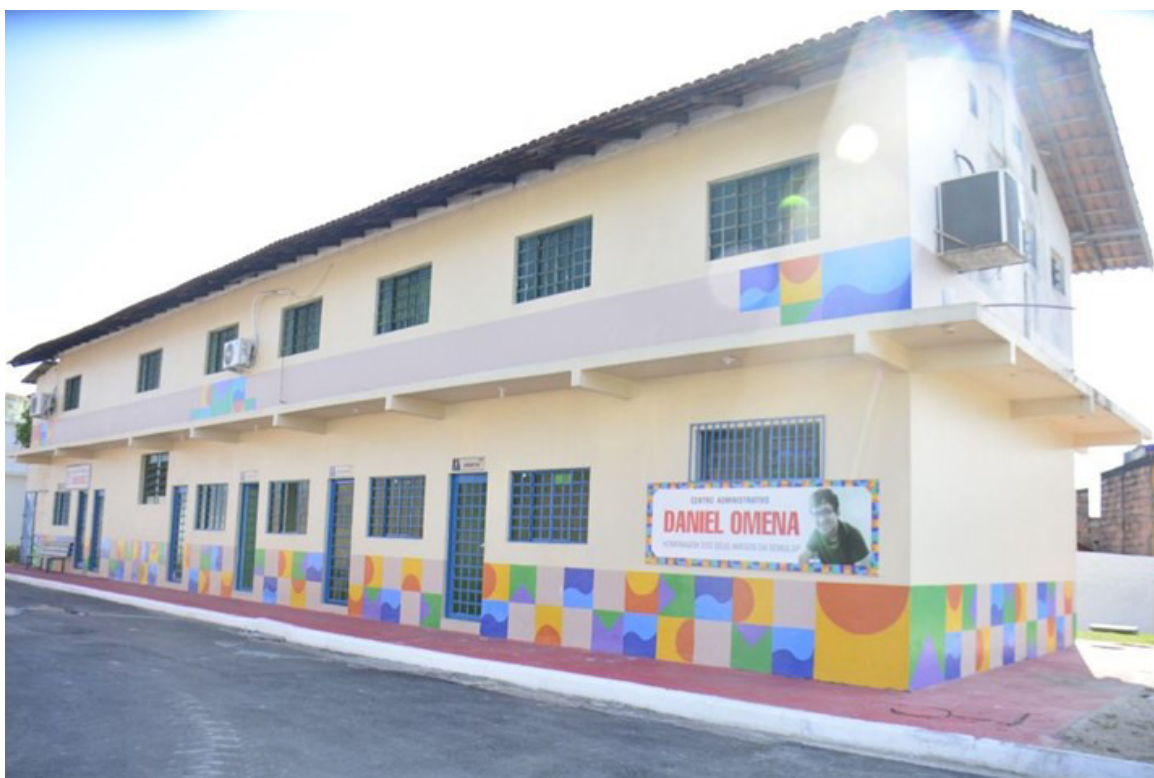
Figura 4: Sede da Semulsp revitalizada
