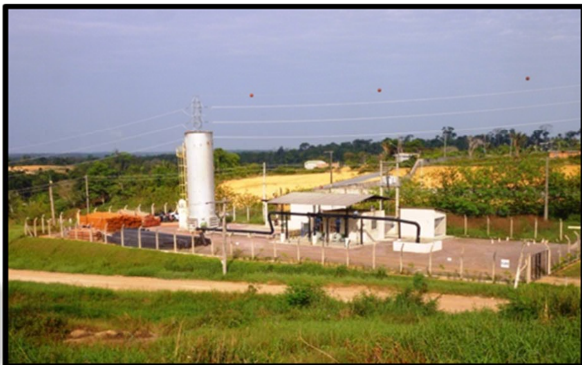
Figura 26 Planta da queima do Biogás
