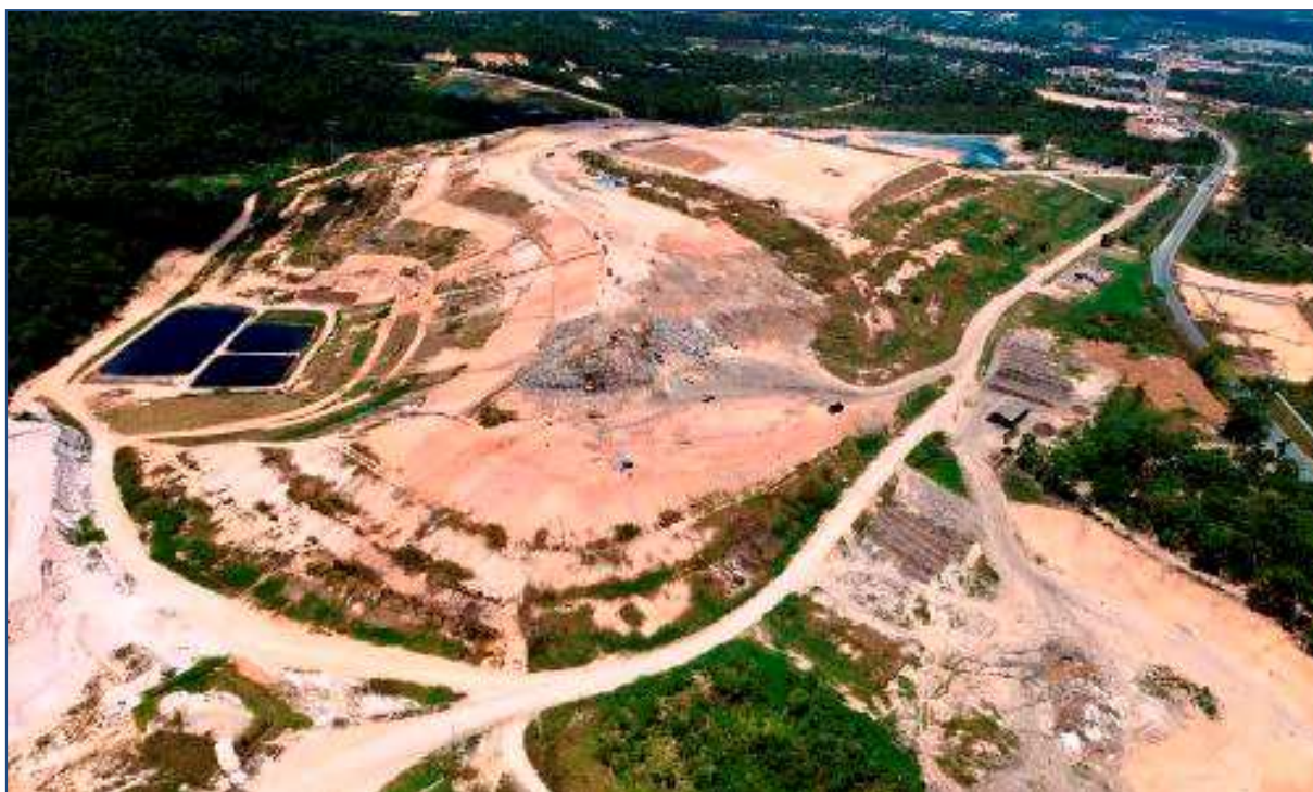
Figura 8 Vista aérea do Aterro
