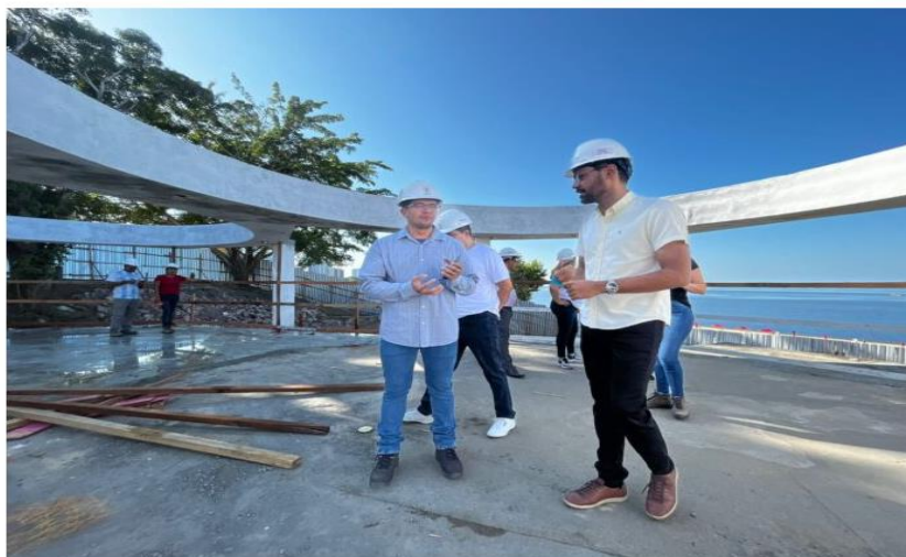
Obras do Local Casa de Praia . Foto: Lúiza Maria / Semtepi
