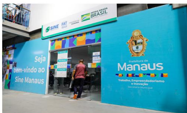
30.06.22 - Prefeitura de Manaus anuncia serviço de reforma para obras de ampliação do Sine Manaus
