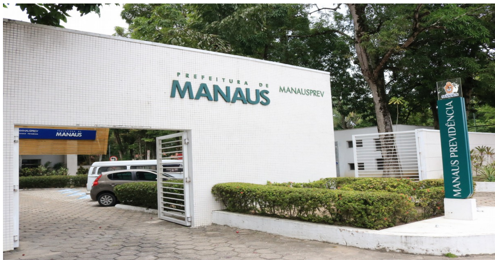
Nova sede da ManausPrev: Manaus Previdência (foto: sítio do órgão)
