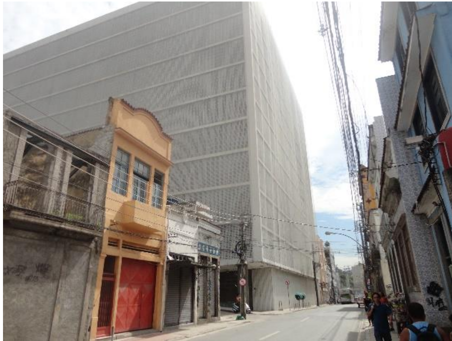
Figura 7 - Rua do Livramento com imóvel à esquerda
