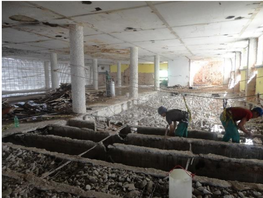
Figura 9 - Vista interna da obra
