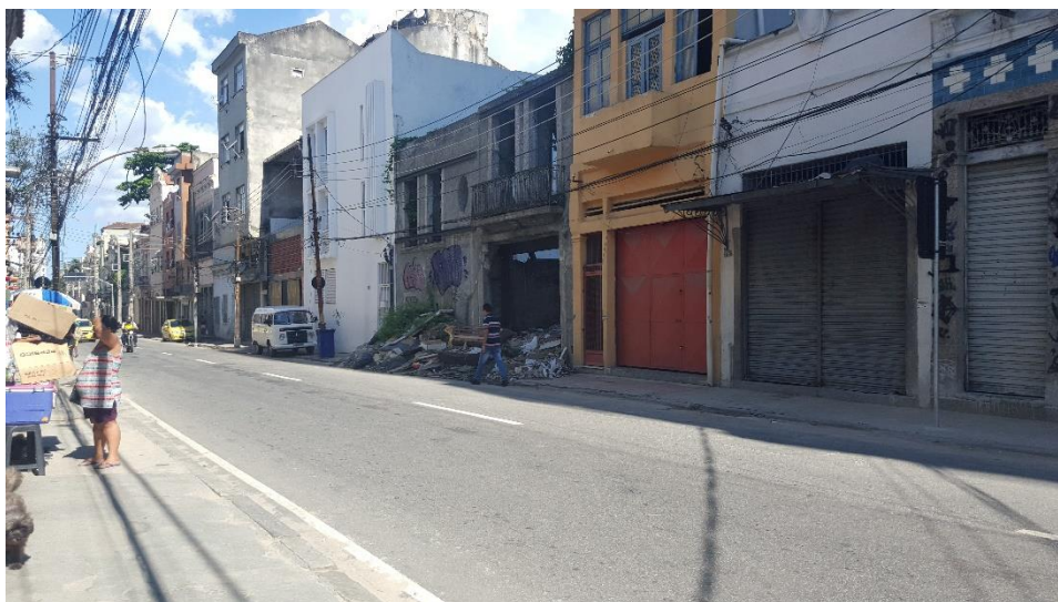
Figura 14 - Vista da rua, imóvel à esquerda
