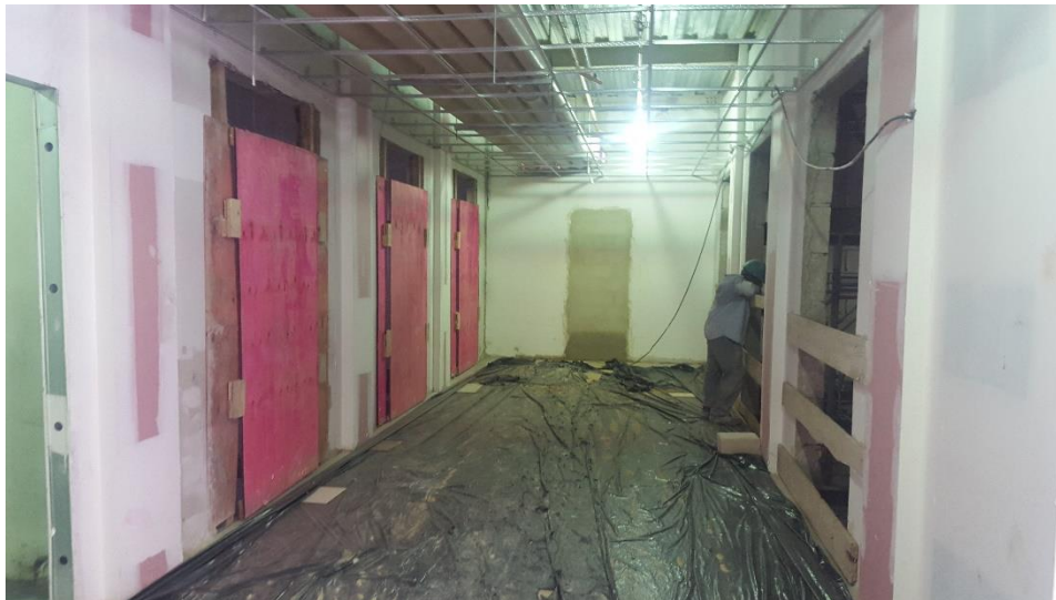
Figura 11 - Vista dos Elevadores
