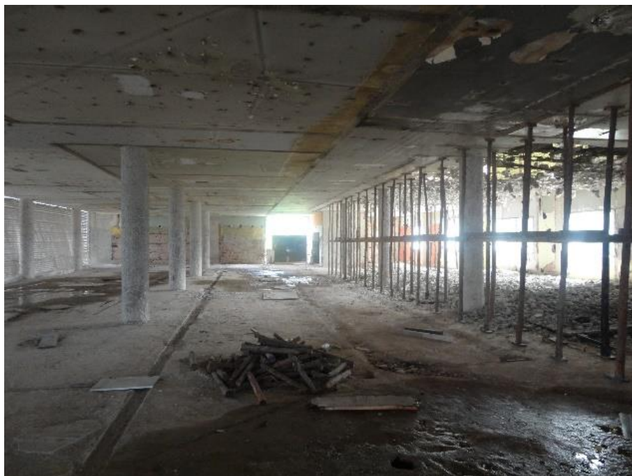
Figura 10 - Vista interna da obra
