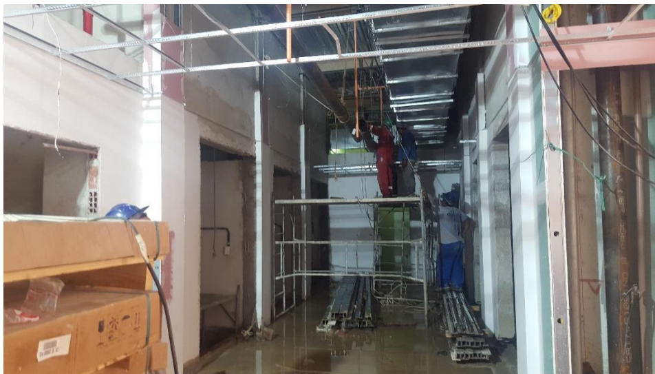
Figura 12 - Vista do Hall do Elevador
