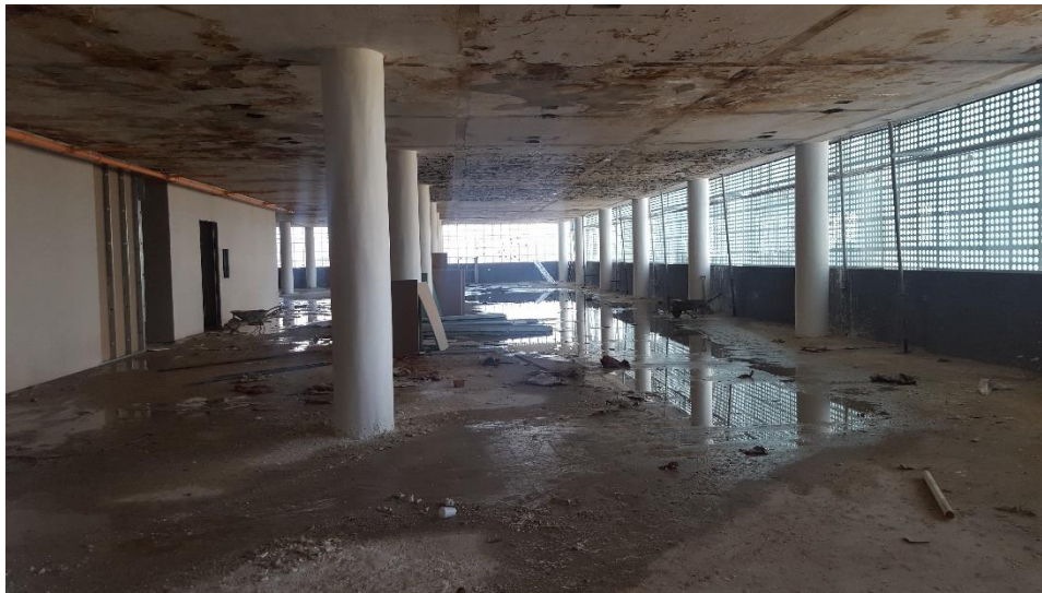
Figura 10 - Vista do pavimento 11º
