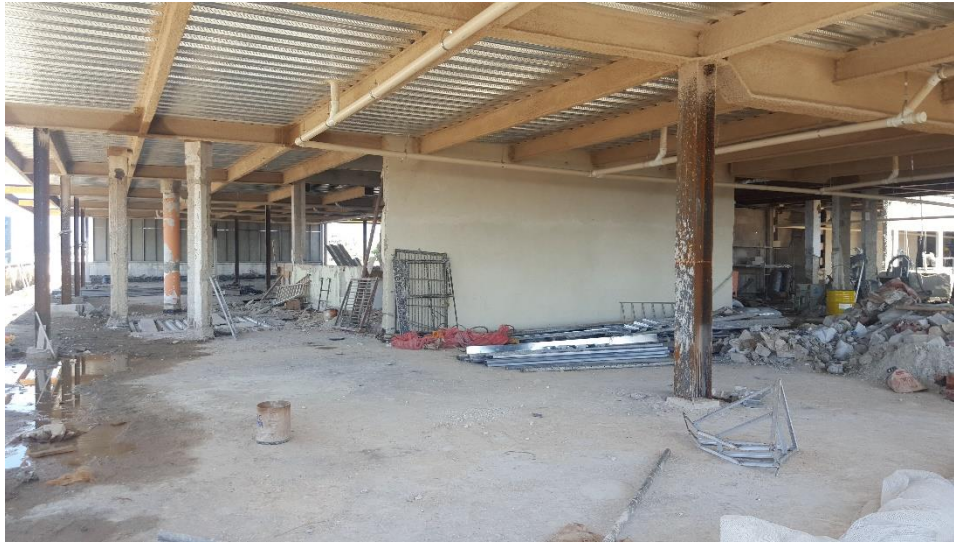
Figura 9 - Vista da cobertura
