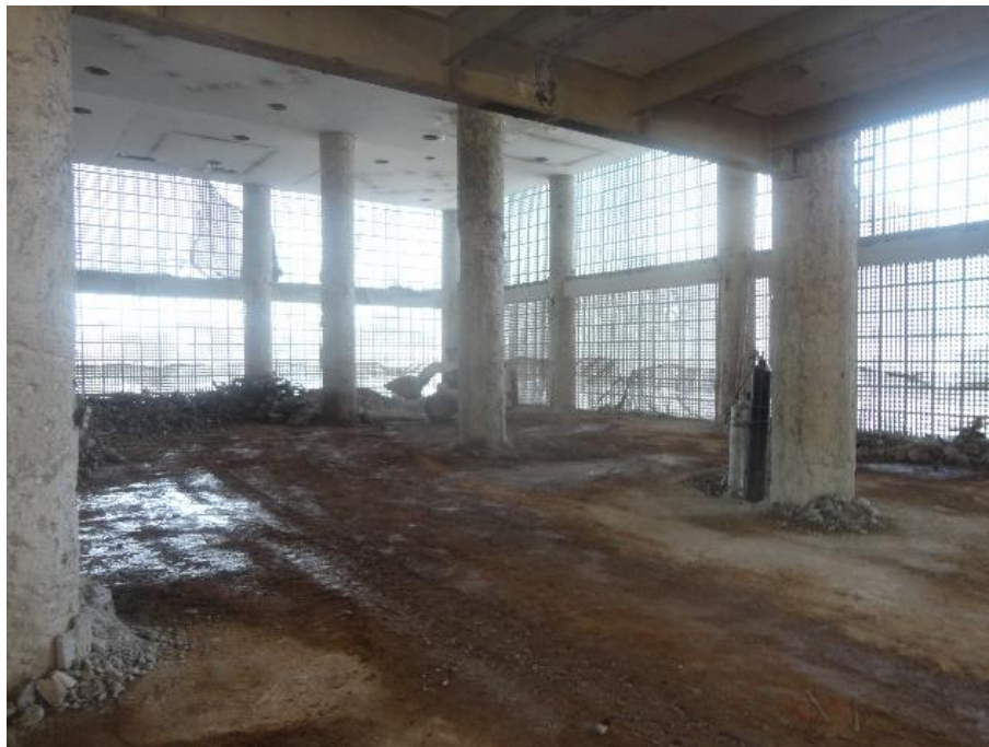
Figura 12 - Vista interna da obra
