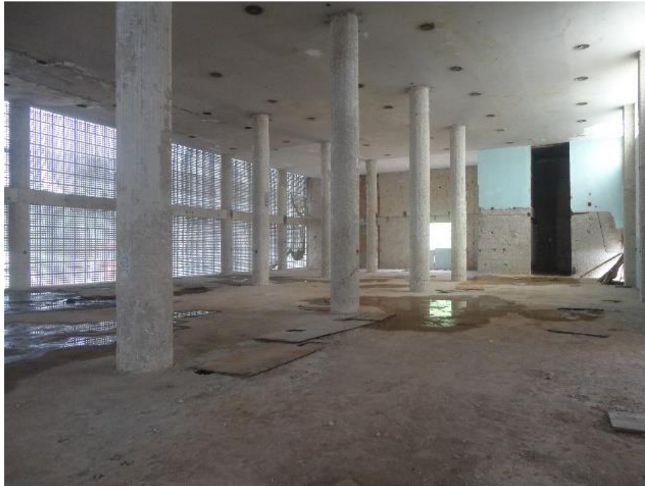
Figura 11 - Vista Interna da obra
