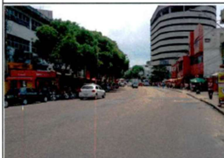
Figura 2 - Vista logradouro (Avenida Floriano Peixoto)
