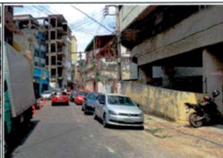
Figura 3 - Vista logradouro (Rua Mundurucus)
