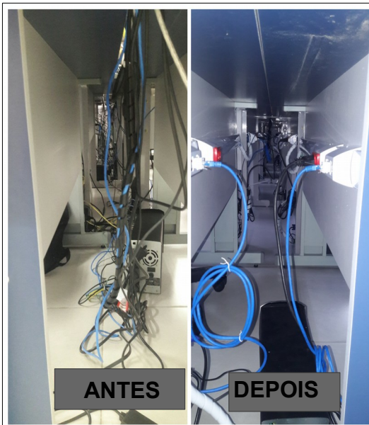
Registro fotográfico da reestruturação de cabeamento de redes de computadores e rede elétrica dos setores
