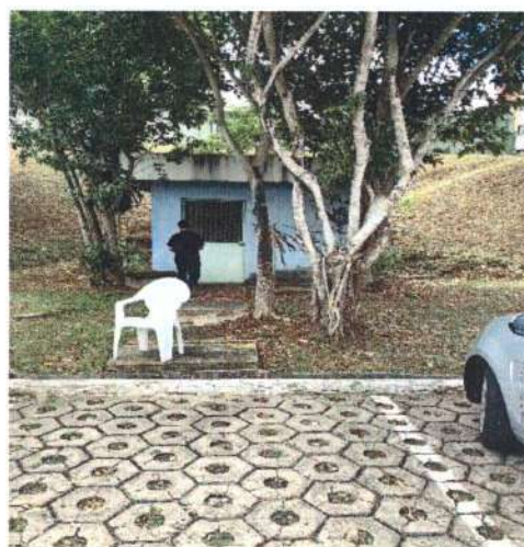
Cubículo de abrigo do transformador.
